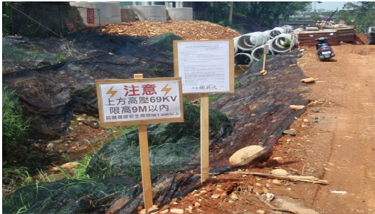
圖 5-4 工地豎立警示牌
