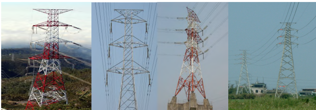
圖 2-4 鐵塔型支持物外觀(用於 345 千伏、161 千伏、69 千伏)
