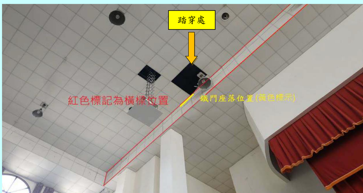
自活動中心一樓舞台前地面向夾層天花板拍攝
